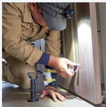
▲チェック箇所をヘッドライトで照らしながら、一つひとつ細部まで手作業で補修。
