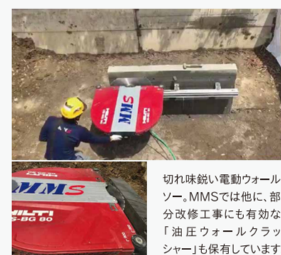
切れ味鋭い電動ウォールソー。MMSでは他に、部分改修工事も有効な「油圧ウォールクラッシャー」も保有しています。
